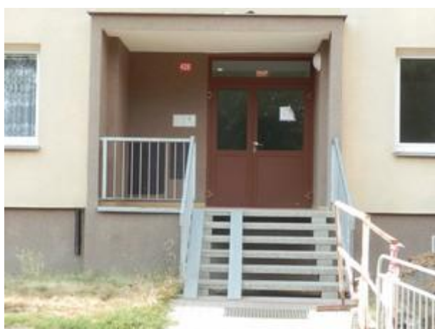
Vstup do sekce č.p. 426
